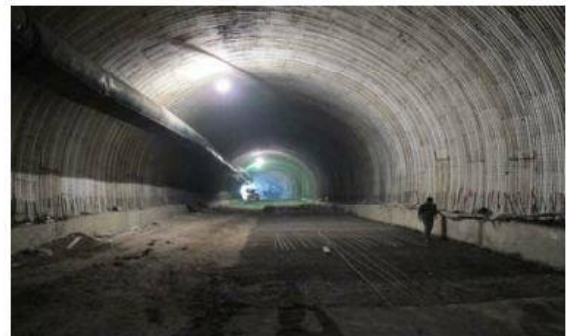
طرح و اجرا و نظارت تونل بختیاری به روش لاینینگ تک پوسته ای سریع الاحداث
