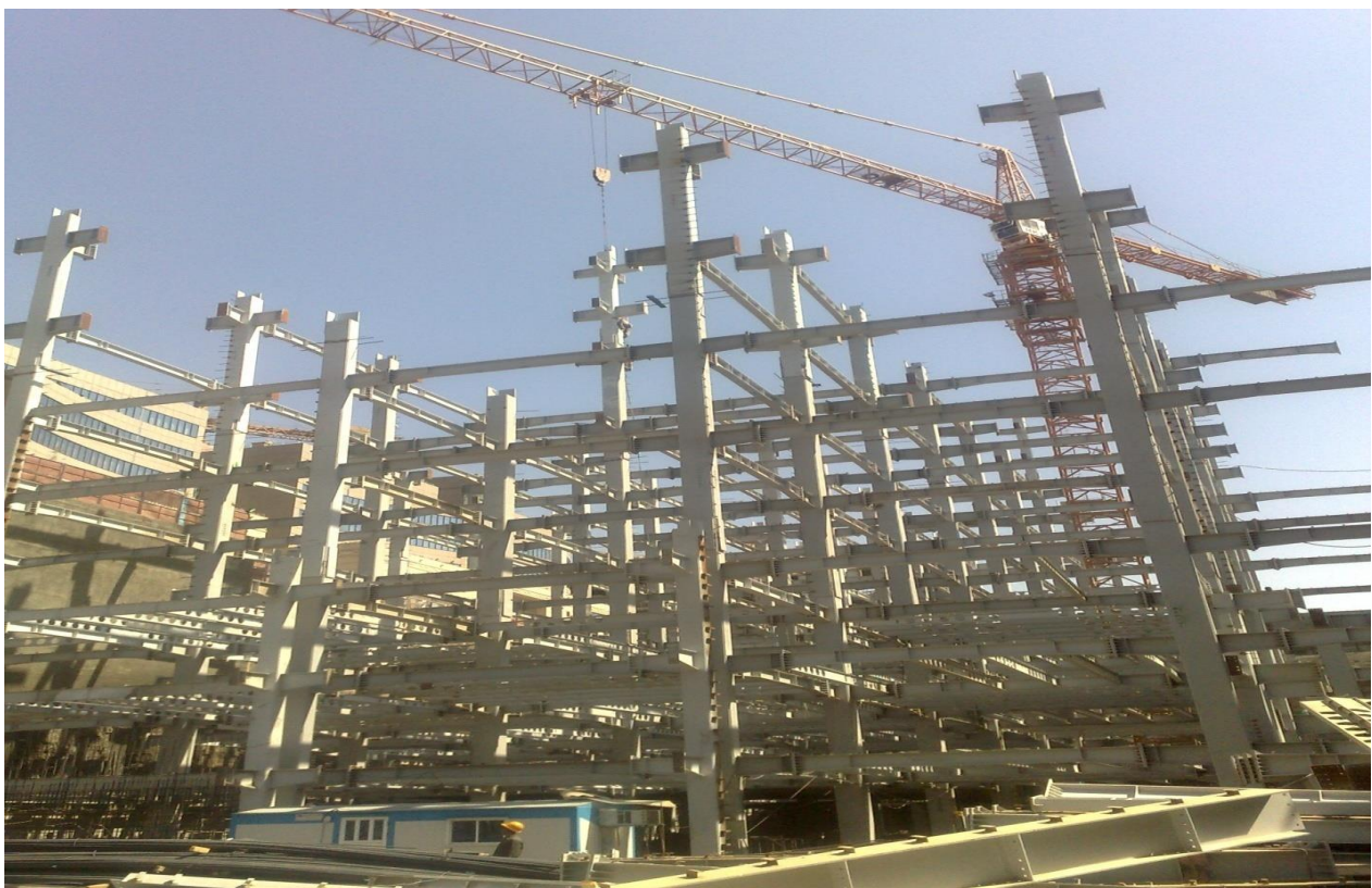
اسکلت مجتمع تجاری مسکونی هتل قدس رضوی مشهد
