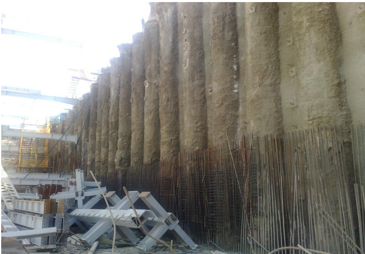
طرح و اجرای پایدارسازی خاک با روش توام نیلینگ و شمع
