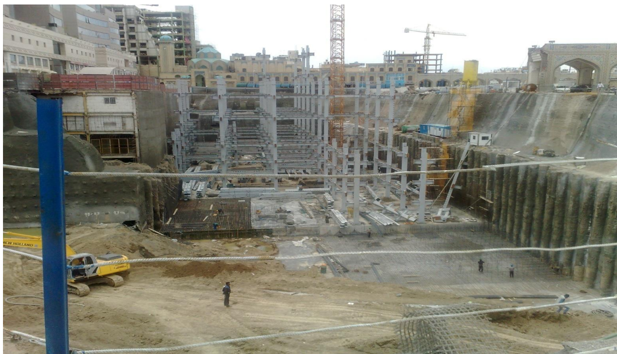
طرح و اجرای نیلینگ و گود برداری به عمق ۲۵ متر مشهد
